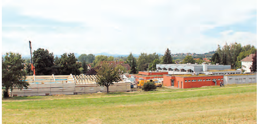
Das Richtfest ist vollzogen: Bereits Ende November soll das neue Musikhaus des Musikverein Markelfingen bezugsfertig sein.
