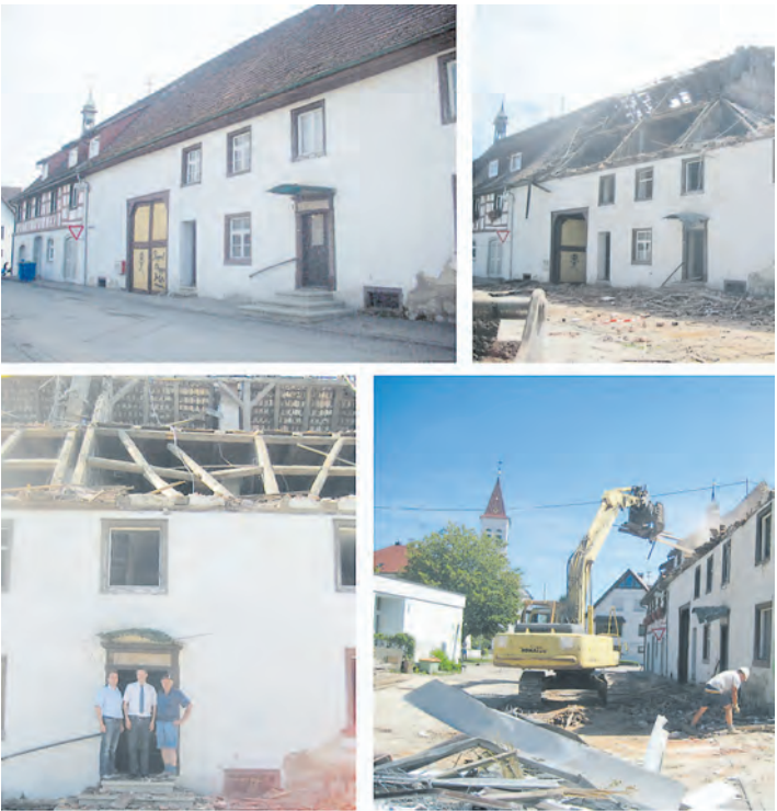
Ein großer Schritt für Eigeltingen: Das Gebäude neben dem Rathaus in der Krumme Straße wird wegen der geplanten Erweiterung des Verwaltungssitzes abgebrochen. swb-Bilder: Gemeinde Eigeltingen
