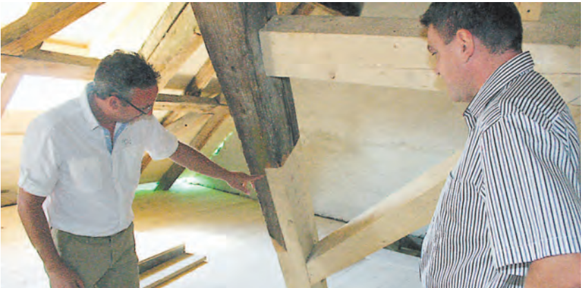
Christian Massler von der Firma Holzbau Massler erklärte Bürgermeister Andreas Schmid im Dachstuhl die schwierige Arbeit, altes mit neuem Holz zu verbinden.
