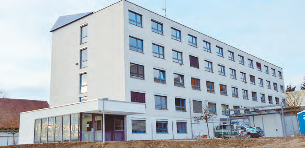
Für Kosten in Höhe von etwa 375.000 Euro hat das Polizeirevier Stockach nach einer etwa einjährigen Bauzeit einen neuen Eingangs- und Schleusenbereich erhalten. swb-Bild: Weiß
