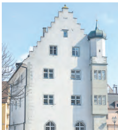
Ein Foto aus der Vergangenheit: Derzeit bestimmen Gerüste und Bauzäune das Bild des Österreichischen Schlösschens. swb-Bild: gü
