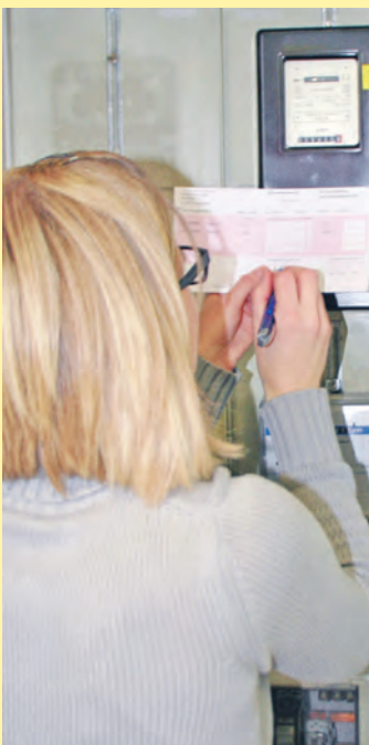
Zukünftig können die Kunden der Stadtwerke Radolfzell zeitlich flexibel ihre Verbrauchszähler selber ablesen.
