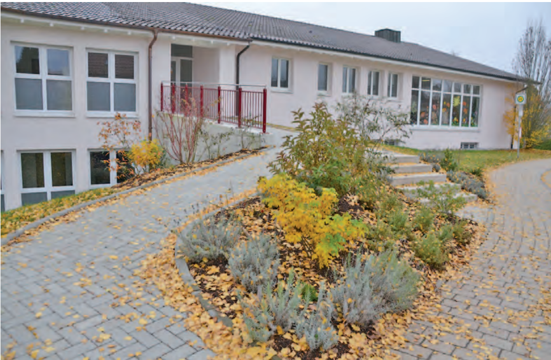
Die Kosten für die neuen Anbauten an die Schule und den Kindergarten in Nenzingen schlagen im Haushalt besonders stark zu Buche. swb-Bild: Weiß
