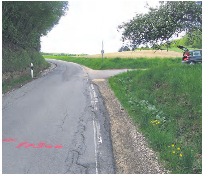
Die K 6119 wird wegen Bauarbeiten bis Freitag, 30. August, voll für den Verkehr gesperrt. sub-Bild: Gemeinde Eigeltingen
