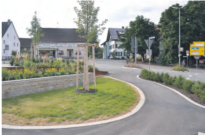
Die Sanierung von Gemeindestraßen wird verschoben.
