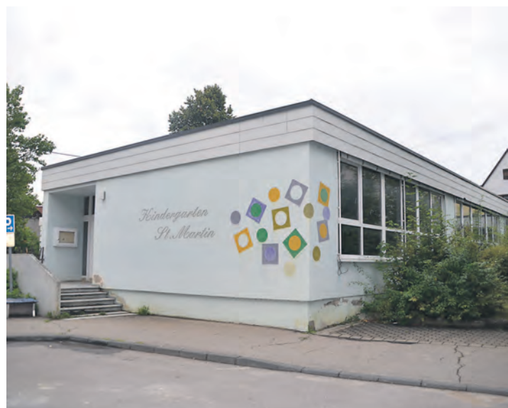
Der alte Kindergarten an der Krumme Straße neben dem Rathaus in Eigeltingen soll abgerissen werden. swb-Bild: sw
