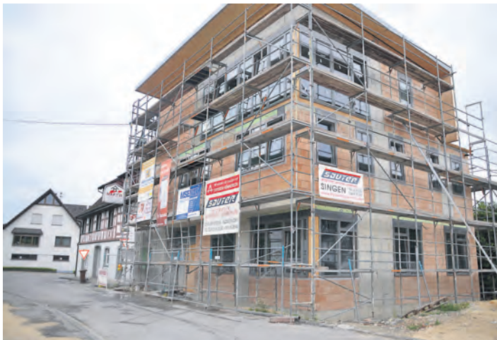
Die Arbeiten am Eigeltinger Rathaus in der Krumme Straße schreiten zügig voran. swb-Bild: sw
