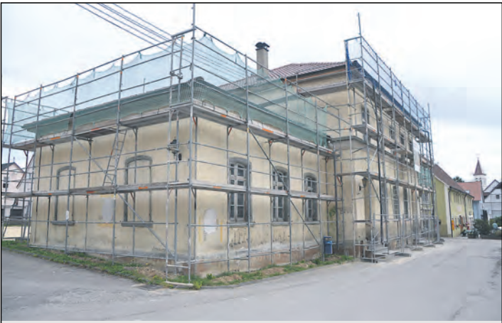
Die »Alte Post« an der Hauptstraße in Eigeltingen wird gerade umgebaut, damit im Erdgeschoss ein Lebensmittelmarkt einziehen kann. Bürgermeister Alois Fritschi rechnet mit einer Fertigstellung bis Herbst 2014. swb-Bild: Weiß
