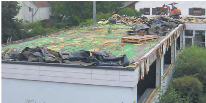
Der »alte« Kindergarten wird gerade abgerissen.
