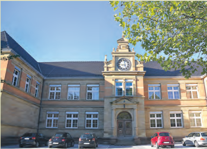
Die Grund- und Werkrealschule (GuW) in der Tuttlinger Straße in Stockach wurde im Zuge einer aufwändigen Baumaßnahme saniert. swb-Bild: sw
