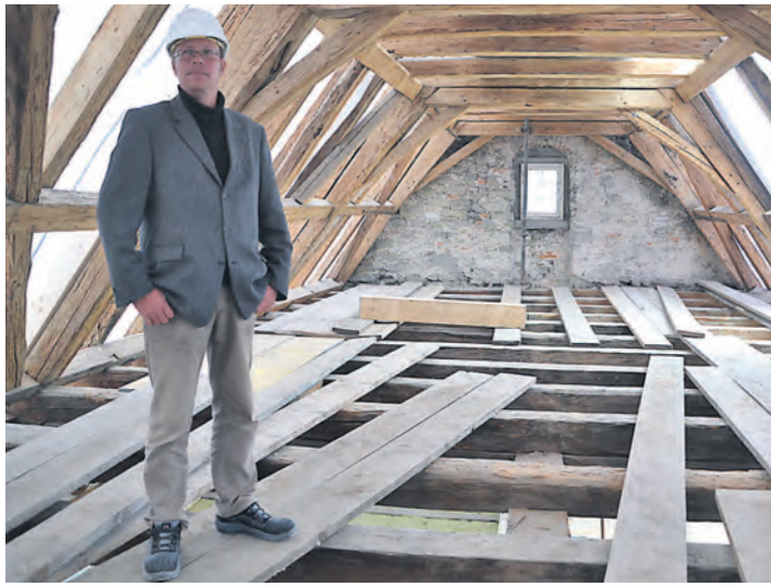
Bis unters Dach führte Thomas Nöken, Fachbereichsleiter Bauen, die Vertreter der Presse, um über die Fortschritte der Sanierungsarbeiten am Österreichischen Schlösschen zu berichten. swb-Bild: gü
