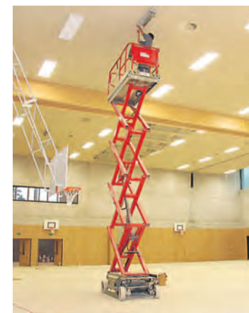
Ins Finale geht bereits der Innenausbau der neuen Hoga-Sporthalle in Stein am Rhein.
