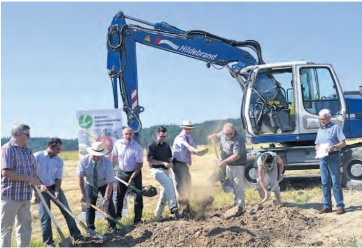
Der Badisch-Landwirtschaftliche Hauptverband (BLHV) baut sich ein neues Zuhause: Im Juli erfolgte der erste Spatenstich für die neue Bezirksgeschäftsstelle im Gewerbegebiet »Blumhof«.
