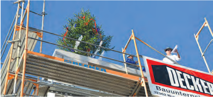
Zum Richtfest im Oktober strahlte der Himmel: Bis August 2014 soll das etwa 14 Millionen Euro teure neue Seniorenzentrum in der Zoznegger Straße fertig gestellt sein.
