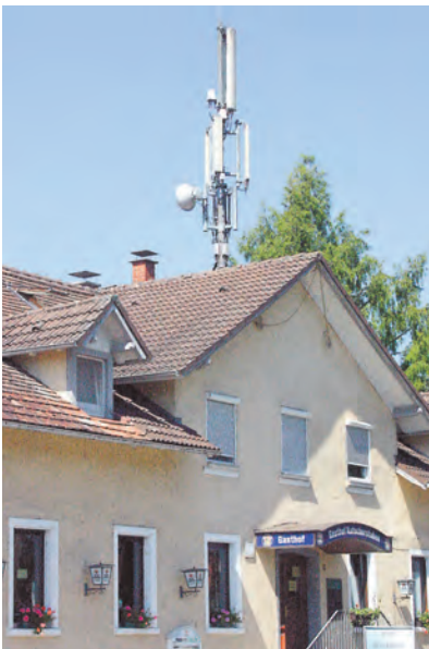
Noch bis 2016 befindet sich eine Mobilfunkanlage in Markelfingen auf dem Gasthaus »Kutscherstuben«. Als Ersatz ist ein Mast am Sportplatz vorgesehen. swb-Bild: pud
