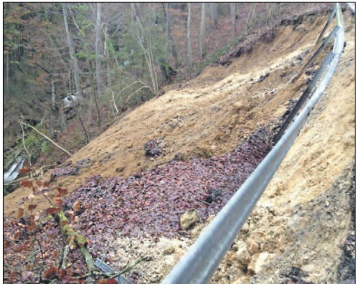
Aufgrund eines Erdbebens musste die K 6137 zwischen Tengen und Büßlingen voll gesperrt werden. Die Dauer der Sperrung ist derzeit nicht absehbar. Eine Umleitung ist ausgeschildert: In Fahrtrichtung Büßlingen über Beuren a. R. und in Fahrtrichtung Tengen über Uttenhofen. swb-Bild: FFW
