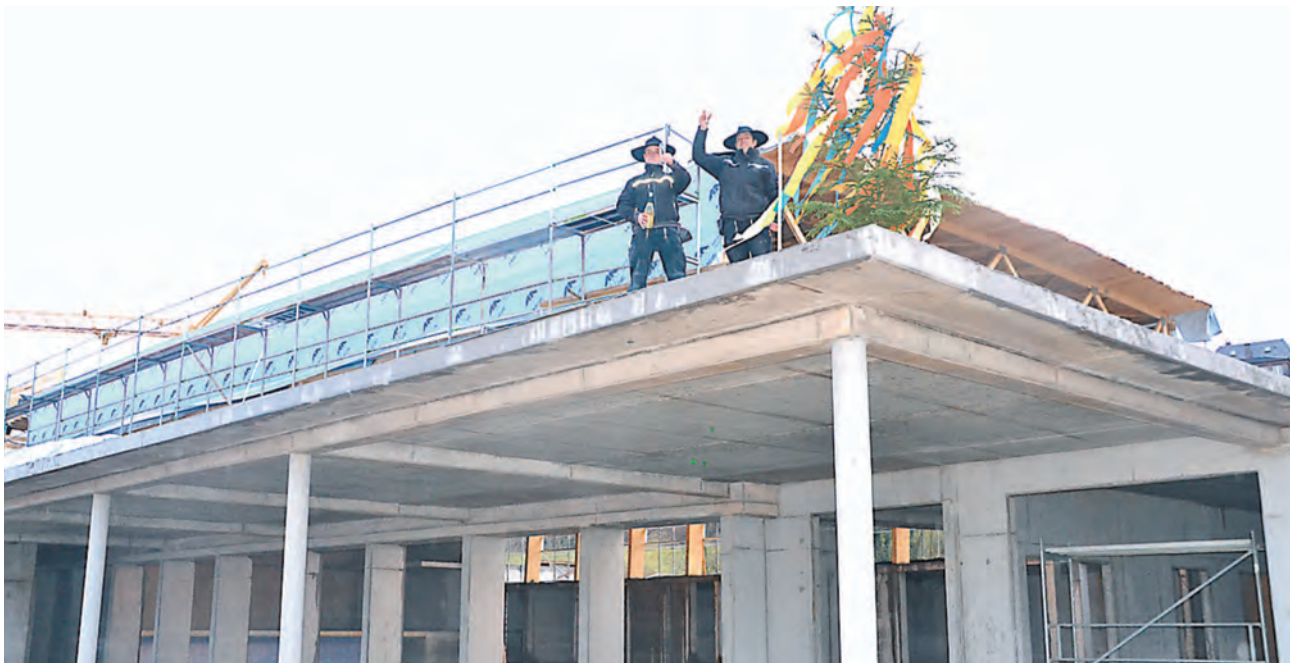
Am Montag wurde das Richtfest der neuen Halle in Engen gefeiert. Bis September soll sie fertig sein.
