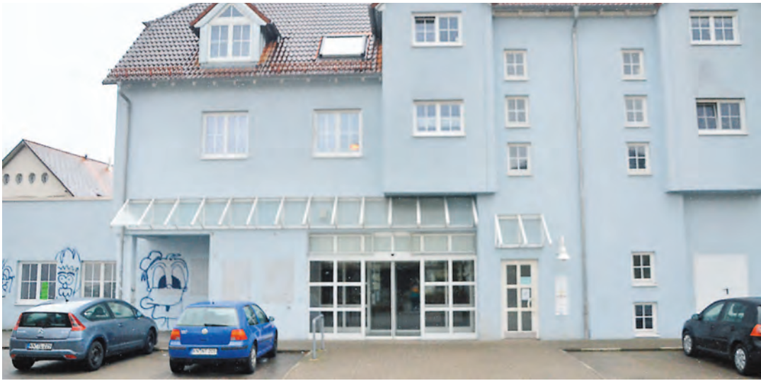
Einöde: Eingang und Parkplatz des ehemaligen Rewe-Marktes sind verweist. An den Wänden des Gebäudes hat ein Kreativer versucht, die Trostlosigkeit zu übermalen.
