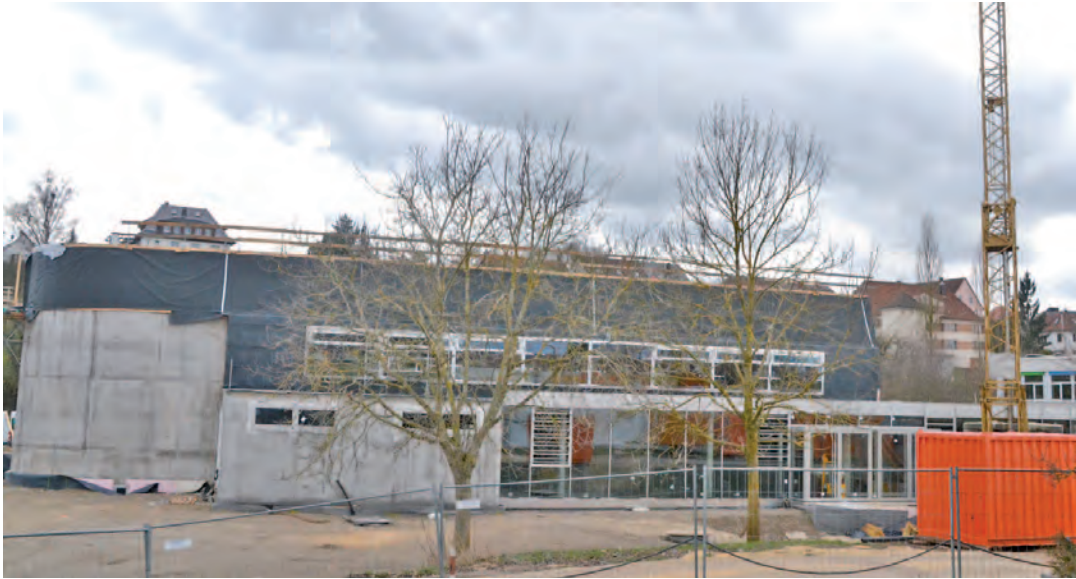
Mit Hochdruck wird derzeit an der neuen Stadthalle in Engen gearbeitet um die baulichen Verzögerungen wieder aufzuholen. sub-Bild: mu
