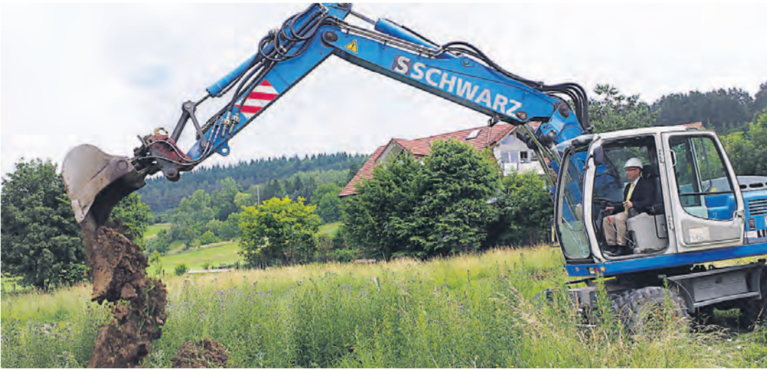
Für Hilzingens Bürgermeister Rupert Metzler war es der erste »Spatenstich« seiner Karriere, der in Twielfeld praktischerweise mit dem Bagger ausgeführt wurde. swb-Bild: of
