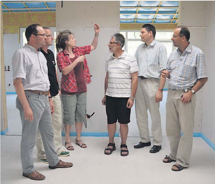
Bürgermeister Severin Graf, Architekt Joachim Binder, Kindergartenleiterin Andrea Hartung, Herbert Wetzel, Christian Jürisch und Werner Hornstein vom Pfarrgemeinderat überzeugen sich vom Fortschritt der Baumaßnahmen. swb-Bild: lkr
