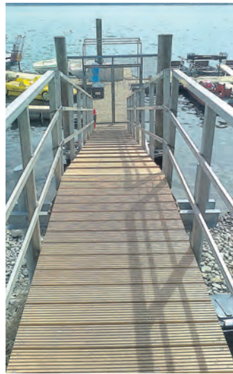
Auf zum See-Erlebnis – der Bootssteg wurde komplett saniert. swb-Bild: Stadt
