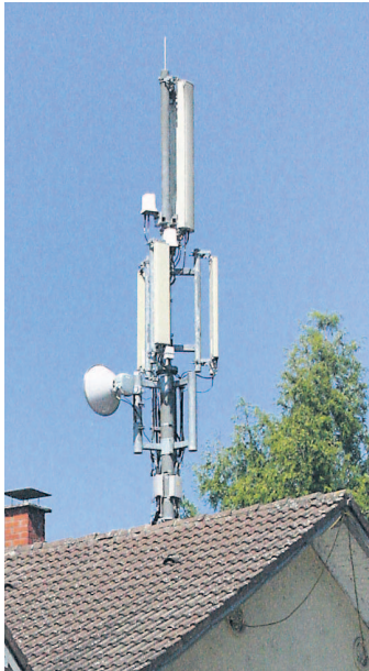
Der alte Funkmast ist dem Mobilfunkbetreiber zu niedrig. swb-Bild: pud
