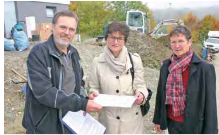
Ewald Müller (l.) und Dagmar Moll (r.), beide Anwohner der Lindenallee, übergaben Bürgermeisterin Monika Laule (2.v.l.) vor Ort eine Liste mit 100 Unterschriften. Sie fordern die Verwaltung auf, den Endausbau der Lindenallee sowie den Straßenbau des restlichen Wohngebiets auf der Schafweide in den Haushaltsplan 2014/15 aufzunehmen. swb-Bild: pud
