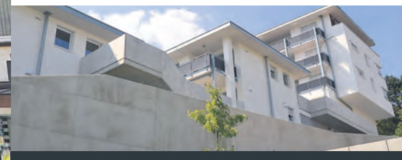
Terrassenförmig abgestuft schmiegen sich die drei Gebäuderiegel in den Hang auf dem ehemaligen Gelände der »Schlosserei Alber«.
