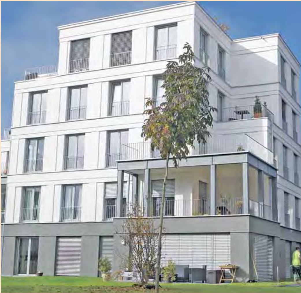
Die Wohnungen im »Aachgarten« sind so geschickt gestaltet, dass auch die Balkone ein Terrassengefühl vermitteln können. Und auf dem Dach gibt es auch noch einen Garten.
