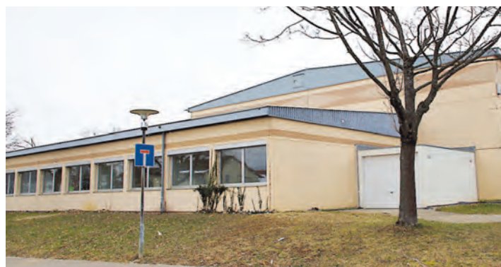
Die Sanierung der Hardberghalle, bei der auch eine Aufstockung der Vereinsräume vorgesehen ist (im Bild), wird um einiges teurer als zunächst geplant.
