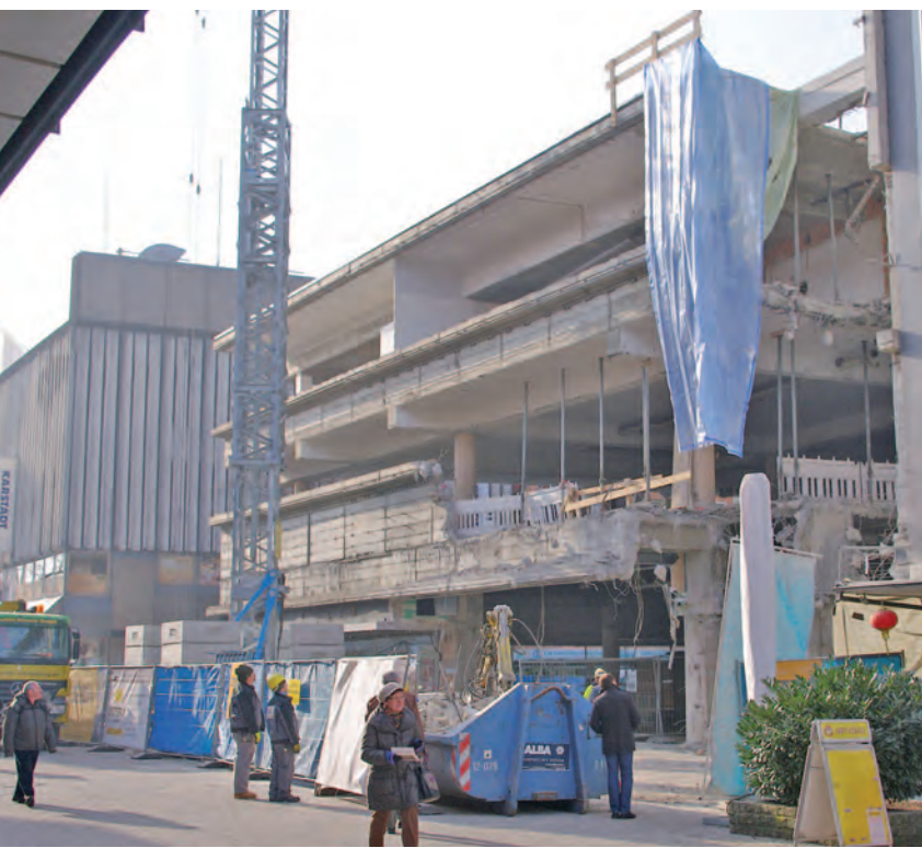
Bis auf den Betonkern zurückgebaut ist derzeit das ehemalige »Bilka«-Gebäude an der Singener August-Ruf-Straße. Bis zum Herbst wollen hier Woolworth, »K&L Ruppert« sowie eine zweite Filiale des Modediscounters »H&M« eröffnen.
