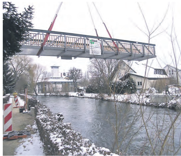
Mit einem Kran wurde der neue Aachsteg an seinen Platz gehoben. swb-Bild: Gemeinde
