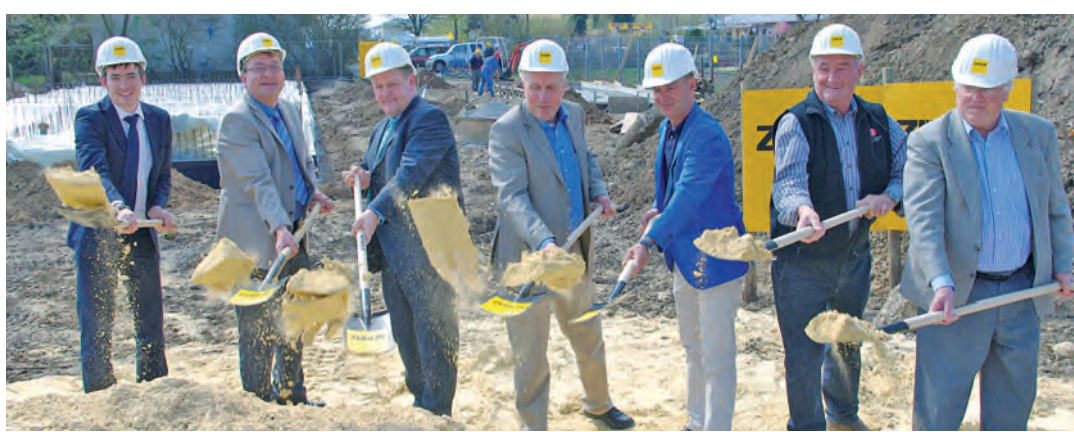
Der Spatenstich war angesichts begonnener Bauarbeiten symbolisch: Tobias Brendgens, Roland Grundle von der GVV und OB Oliver Ehret, Joachim Dannecker vom Bauunternehmen Züblin, Tankstellenbetreiber Hans Ley, Architekt Ewald Gut und Aufsichtsrat Hermann Stocker bei der Arbeit. swb-Bild: of
