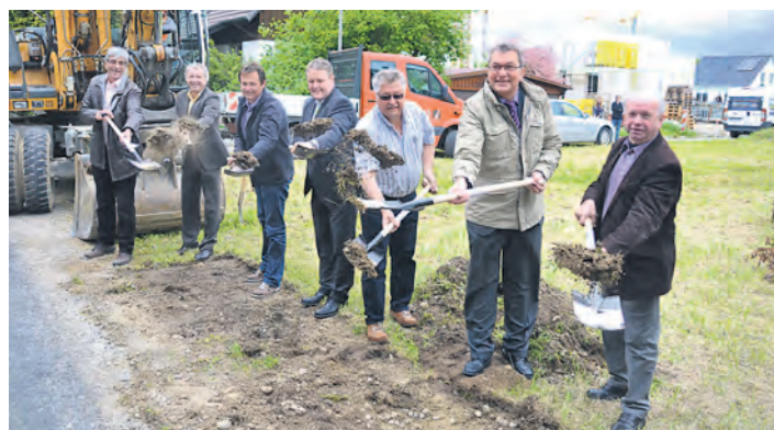
Tiefbauingenieur Norbert Baur, Axel Goedicke, Leiter des Fachbereichs Bauen, Stephan Einsiedler, OB Oliver Ehret, Gemeinderat Wolfgang Werkmeister, GVV Chef Roland Grundler und Ortsvorsteher Adolf Oexle beim Spatenstich im Eichbühl. swb-Bild: stm
