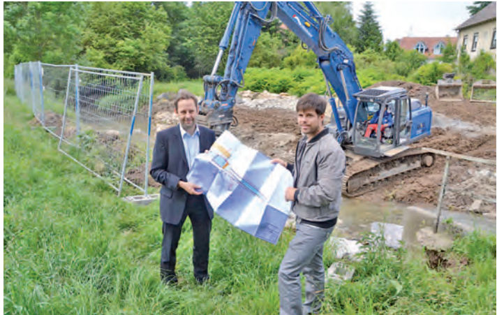
Bürgermeister Dr. Michael Klinger und Bauamtsmitarbeiter Patrick Pingitzer zeigen den Plan für die Renaturierung. swb-Bild: lkr
