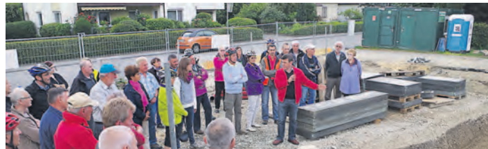
Bürgermeister Artur Ostermaier und Mitarbeiter der Gemeinde an der Baugrube der künftigen Gemeinschaftsschule. swb-Bild: of
