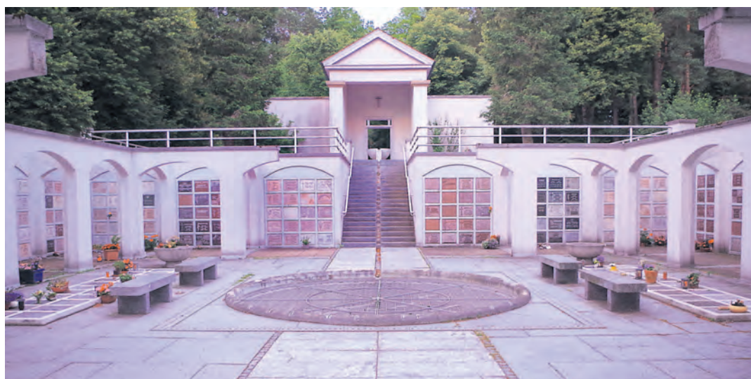
Nach 30 Jahren ist die Urnenwand im Singener Waldfriedhof zum Sanierungsfall geworden. Schon länger hat selbst der Architekt des Bauwerks, Hans-Dieter Schaal, auf den traurigen Zustand seines Werks hingewiesen.
