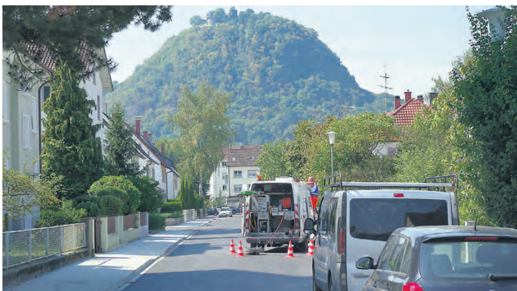
Die letzten Kontrollarbeiten wurden in den letzten Tagen im Lessing-Quartier in der Singener Nordstadt durchgeführt. Ab dem morgigen Mittwoch ist das Gebiet dann nach einem Jahr wieder bauarbeiterfrei.
