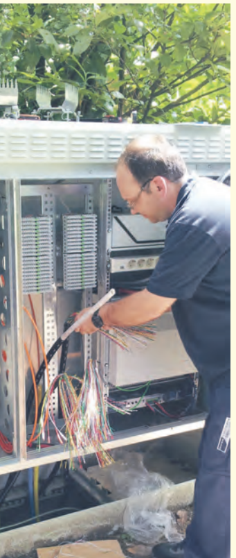
Stadtwerke-Mitarbeiter Michael Mader beim Anschluss eines DSL-Zugangskonzentrators (DSLAM) in Güttingen.
