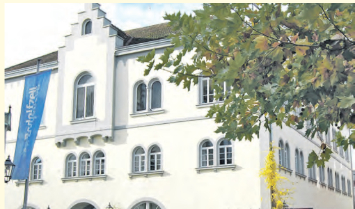
Stadt Radolfzell – ab 2014 gut versorgt durch die Stadtwerke Radolfzell
