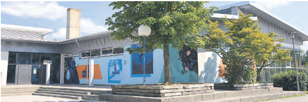
Das Hallenbad an der Dillstraße hat seine Pforten wieder für Badefans geöffnet. swb-Bild: sw
