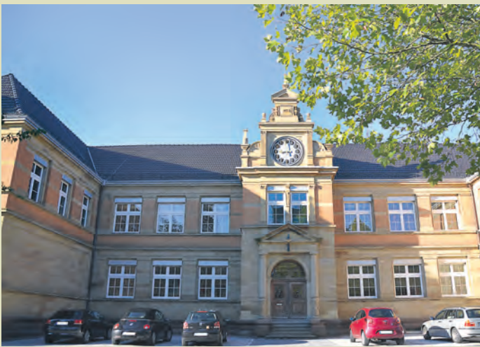
Die Grund- und Werkrealschule (GuW) in der Tuttlinger Straße in Stockach wurde im Zuge einer aufwändigen Baumaßnahme saniert. swb-Bild: sw
