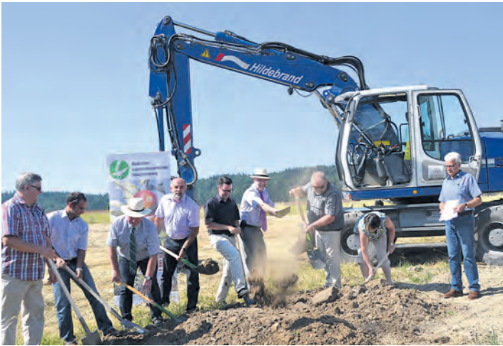
Der Badisch-Landwirtschaftliche Hauptverband (BLHV) baut sich ein neues Zuhause: Im Juli erfolgte der erste Spatenstich für die neue Bezirksgeschäftsstelle im Gewerbegebiet »Blumhof«.
