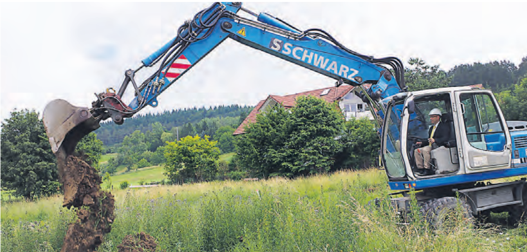
Für Hilzingsens Bürgermeister Rupert Metzler war es der erste »Spatenstich« seiner Karriere, der in Twielfeld praktischerweise mit dem Bagger ausgeführt wurde. swb-Bild: of
