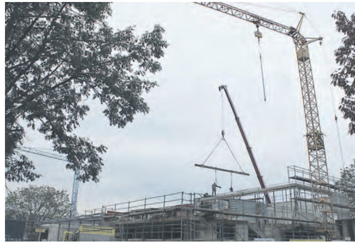
Hochbetrieb herrscht an der Baustelle des Feuerwehrgerätehauses. swb-Bild: le
