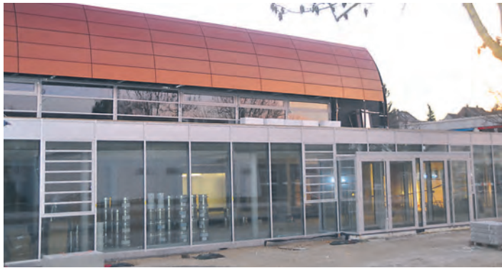
Die neue Engener Stadthalle soll Ende Februar 2014 fertig werden.
