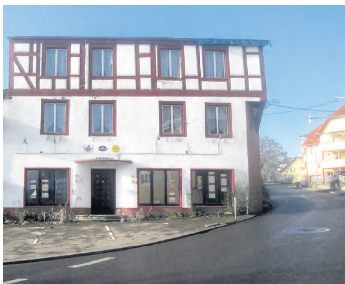
Das ehemalige Gasthaus »Krone« in Aach wird im Frühjahr abgerissen, damit die Straße verbreitert werden kann.
