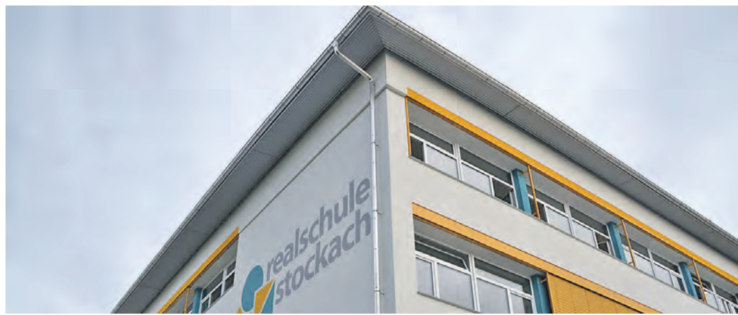
Zwischen Realschule und »Nellenburg-Gymnasium« soll ein neues Schulgebäude entstehen, in das ein Schulverbund aus Real- und Werkrealschule einziehen soll.
