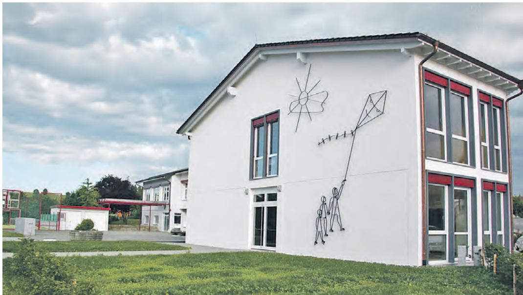
Ein großes Bauprojekt der Gemeinde war der neue Anbau an die Grundschule in Nenzingen, der aber 2013 mit weniger Geld zu Buche schlug. swb-Bild: sw
