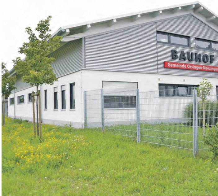
Der Gemeinderat verabschiedete die Satzung für das Gebiet »Eizen I« in Orsingen. In der Nähe des Bauhofs der Gemeinde wird ein zu diesem Areal gehörender Spielplatz entstehen. swb-Bild: sw
