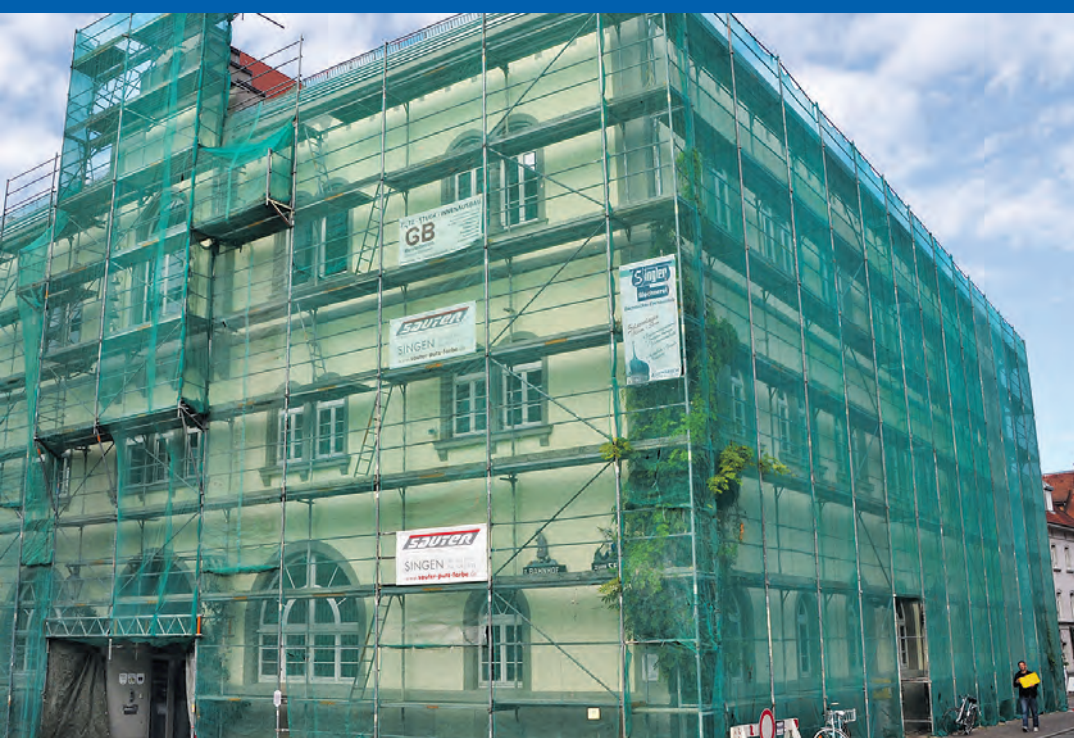
Die Sanierungsarbeiten an der Außenfassade des Radolfzeller Rathauses sind Anfang September abgeschlossen, sodass dann das Fassadengerüst demontiert werden kann und das Rathaus im neuen Glanz erstrahlt. swb-Bilder: stm
