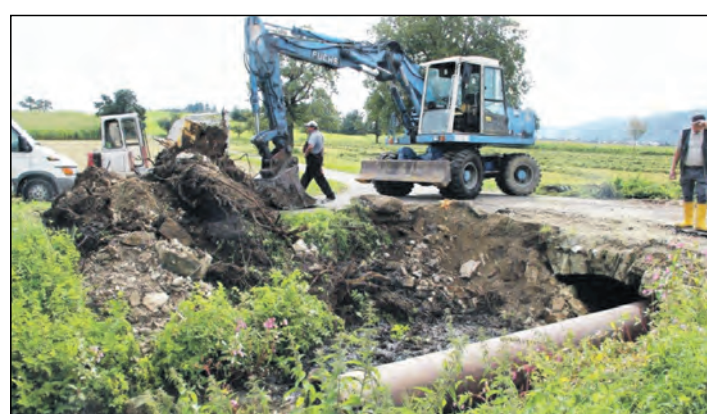
Die Sanierung der Brielbachbrücke in Eigeltingen ist gestartet. Nach drei Jahren habe endlich mit den Bauarbeiten begonnen werden können, so Bürgermeister Alois Fritschi. Er beziffert die Ausgaben für die Baumaßnahme mit 34.510 Euro.
